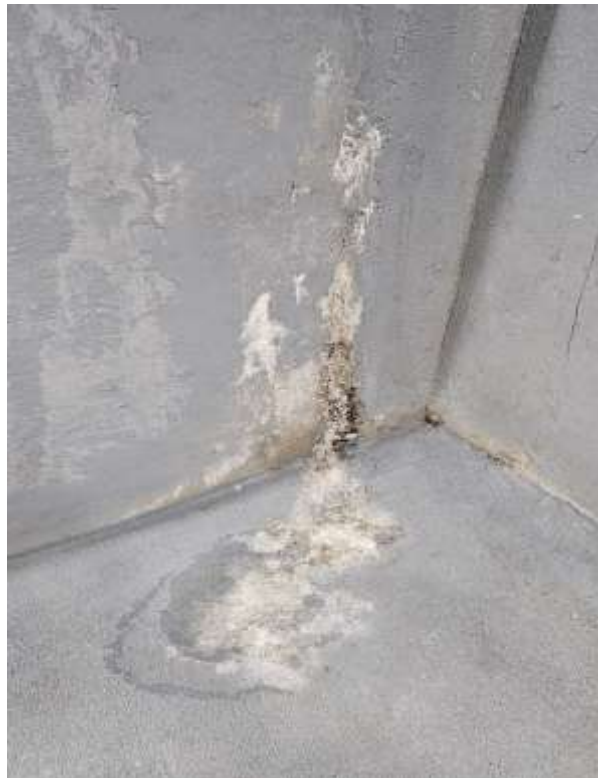
Fot.19. Wyciek wody ze ściany pomiędzy komorą i zbiornikiem.
