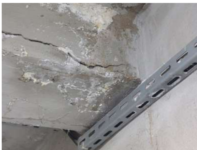
Fot.1,2,3,4,5,6,7. Zniszczone fragmenty żeber i podciągów stropowych.
