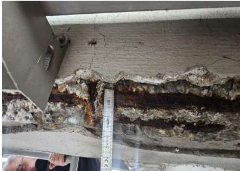
Fot.8,9,10. Pomiary głębokości ubytków betonu.
