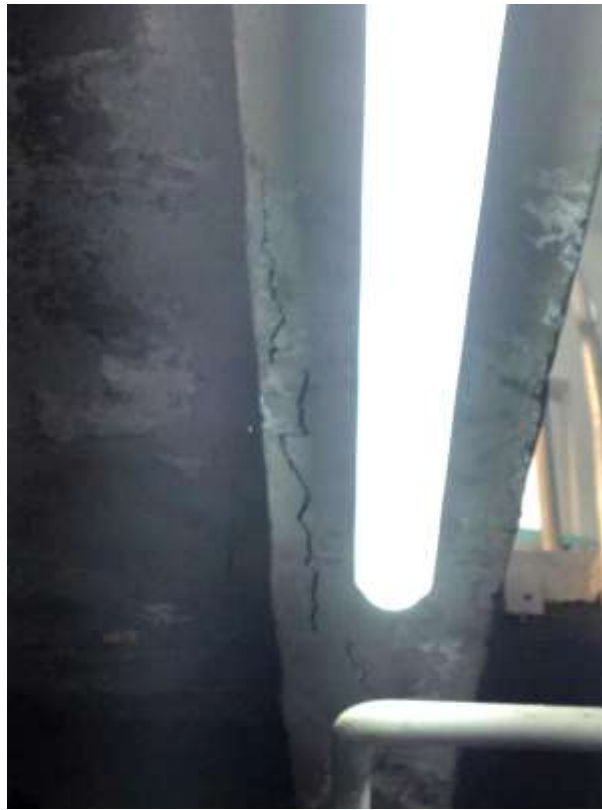
Fot.11,12,13. Podłużne pęknięcia elementów konstrukcyjnych stropu.
