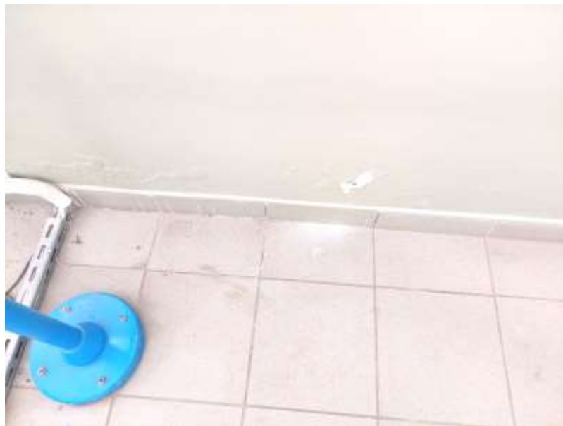
Fot.23. Lokalne uszkodzenie tynku i pęcherze na ścianie zewnętrznej Budynku OWP.
