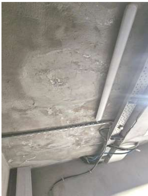
Fot.14,15,16,17. Zawilgocenia i wykwity na powierzchni płyty stropowej.
