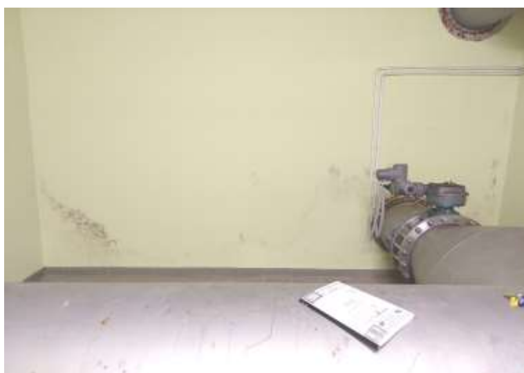
Fot.20,21. Kolonie pleśni na ścianie między pomieszczeniem rurociągów i zasuw a zbiornikami pomp przewałowych.
