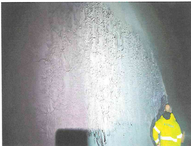
Fot.1,2,3,4. Odspojona od podłoża finalna warstwa izolacji na ścianie zewnętrznej.
