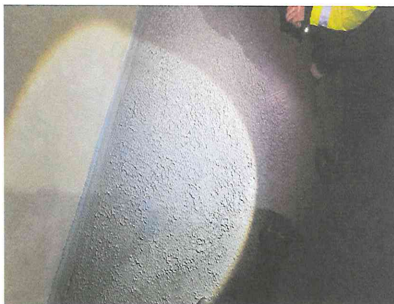
Fot.8,9. Uszkodzone fragmenty izolacji na dnie zbiornika.
