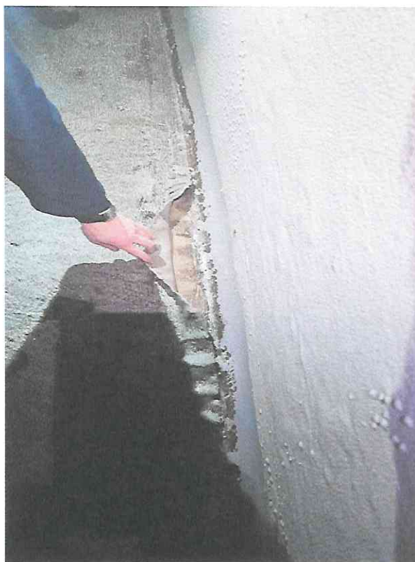
Fot.10,11. Lokalne uszkodzenie powłoki izolacyjnej na taśmie dylatacyjnej.
