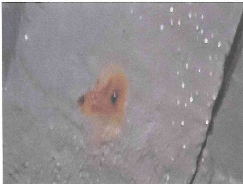
Fot.1,2. Fragmenty stropu zbiornika pokrytego mineralną wyprawą wodoszczelną z ogniskami korozji.
