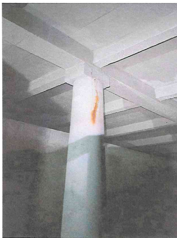
Fot.12,13, Lokalne ogniska korozji odsłoniętych prętów zbrojeniowych.
