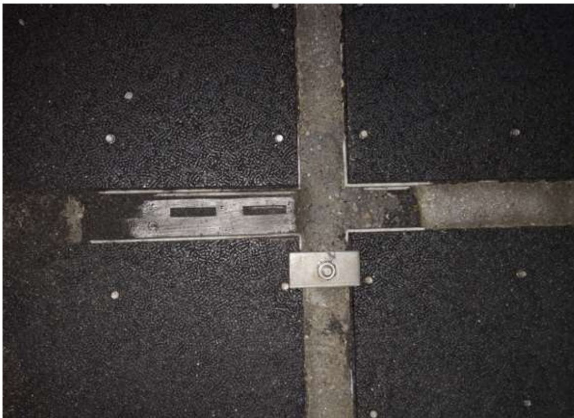
Fot. 5 Uszkodzone wypełnienie między blokami drenażowymi.
