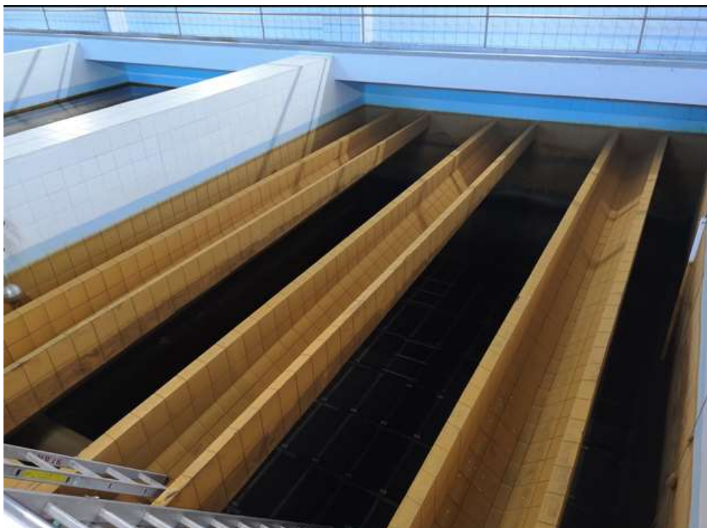
Fot. 2 Koryta zasilające w filtrze nr 3.
